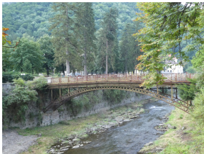
Die gusseiserne Brücke über die Cerna vor dem Neptunbad, 2024. Foto: Josef Sallanz
